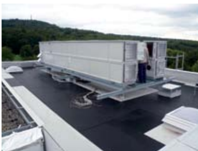
Montage und Anschlussarbeiten der neuen Lüftungsgeräte für den Neubau
