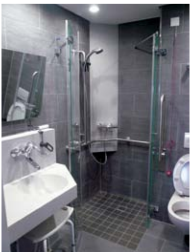
Die neuen Nasszellen mit integrierter Dusche und Duschabtrennungen in Glas
