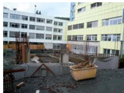
Verlegung der Abwasserkanäle im Bereich der Baustelle. Bauarbeiten im Bereich der Gründungssohle, betonierte Stützwand im Anschluss der neuen Liegandanfahrt zur Arnoldstraße
